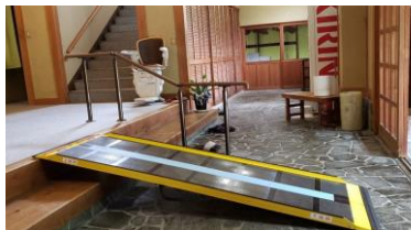
折りたたみ式の簡易スロープの設置
