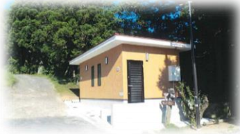
キャンプ場のトイレ整備
