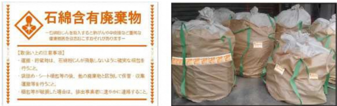
図3-7 石綿含有産業廃棄物の表示テープ
