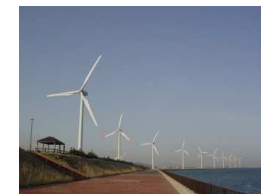
風力発電設備
