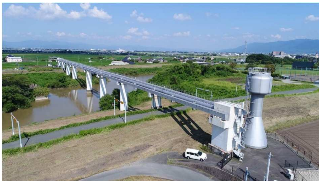
【福岡導水（思案橋水管橋）】
