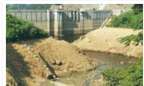
濁水で干上がったダム
