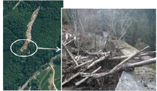
山地災害から人家や道路を守る治山ダム
