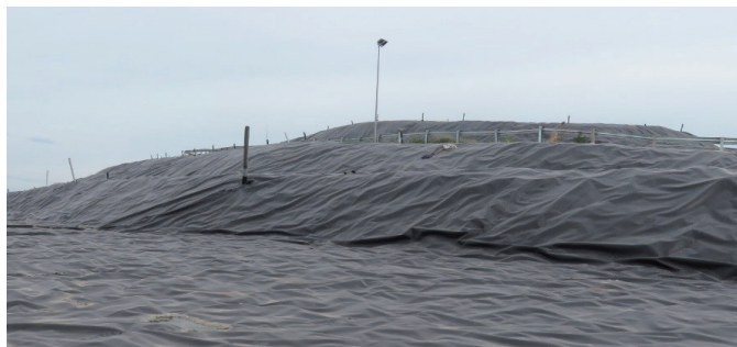
Hoàn thành chôn lấp (Thời điểm tháng 8/2019)
