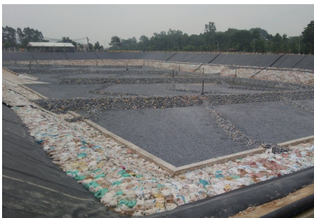
Hoàn thành xây dựng (Tháng 6/2015)
