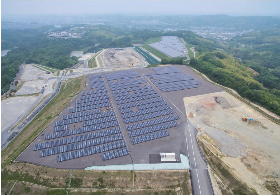
Ảnh: Ví dụ về ứng dụng mặt bằng đất đai (Nhà máy phát điện năng lượng mặt trời: DINS Megasolar)
