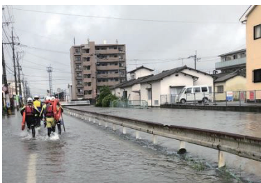
令和元年 7 月の大雨による浸水被害 (筑後川水系池町川(久留米市))
