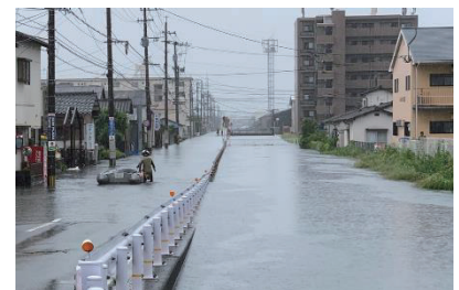
令和 3 年 8 月の大雨による浸水被害 (筑後川水系池町川(久留米市))
