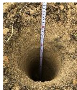
写真2 携帯型穴掘機による排水穴
