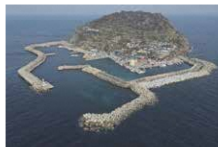
消波ブロックの設置が完了した小呂島漁港
