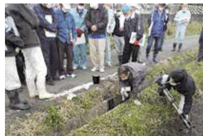
水路補修研修会
