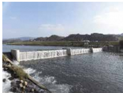
広瀬地区で長寿命化対策が完了した転倒ゲート（みやま市）
