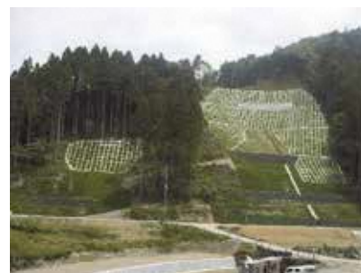
整備された山腹工（朝倉市）
