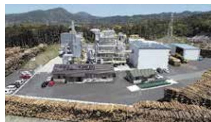
木質バイオマス発電施設（筑前町）
