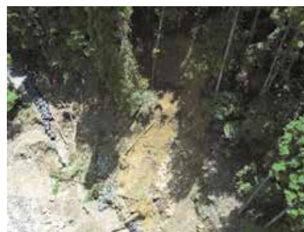
ドローンで空撮した被災林地
