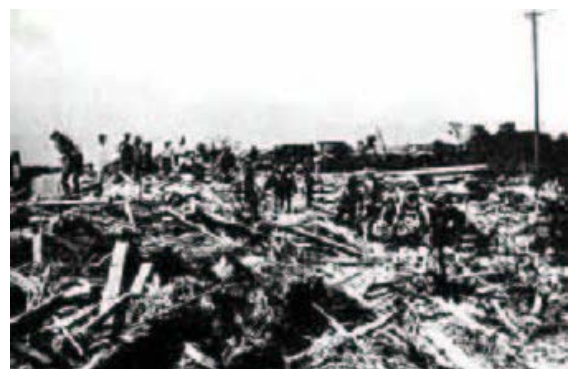
写真 1.4 高潮被害状況 (熊本県熊本市沖新)
