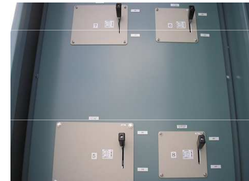
切換盤 (商用電力・災害用発電機電力) (スコットランス含む)
