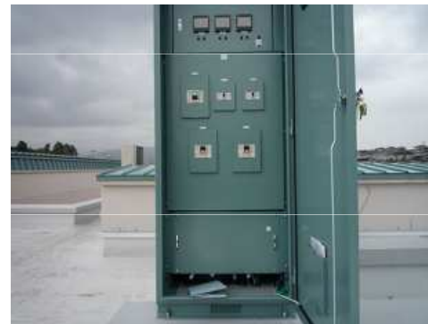
切換盤 (商用電力・災害用発電機電力) (スコットランス含む)
