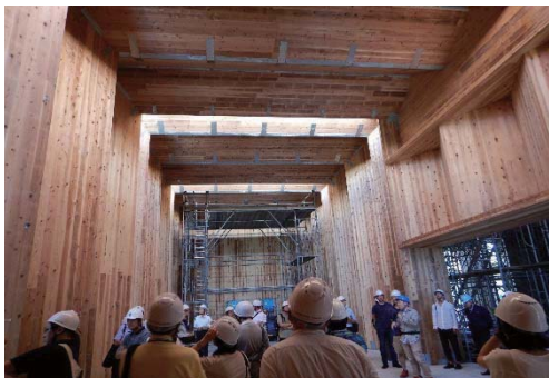
CLT壁パネルの構造、施工の現場見学
