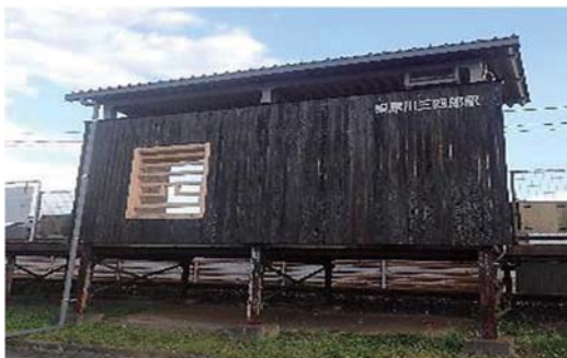
みやこ町産スギを使用し焼杉加工された駅舎外観
