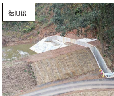
農業用施設（ため池）の復旧（朝倉市）
