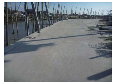
高潮対策の物揚場工事
