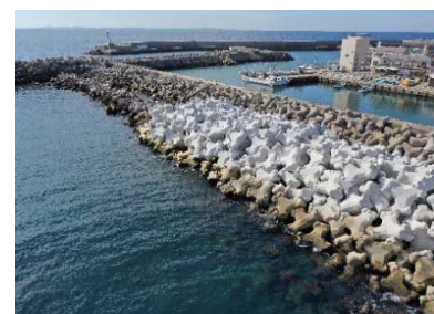
高潮対策の消波ブロック工事
