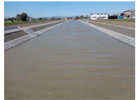
大和中部Ⅱ期 整備状況
