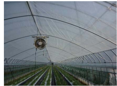
内張カーテン施設と循環扇の導入
