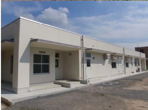
本城送水ポンプ施設
