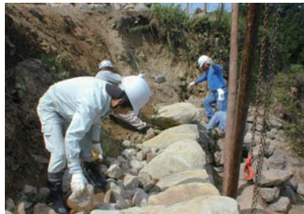
棚田の修復作業（黒木町）
