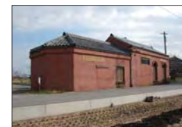
〔歴史的建物〕 ○旧三井寺ポンプ場
