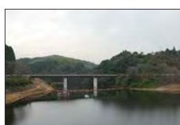
[水辺空間] ○広川ダム
