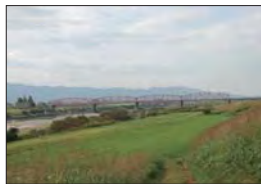
[ 歴史的構造物 ] ○筑後川橋
