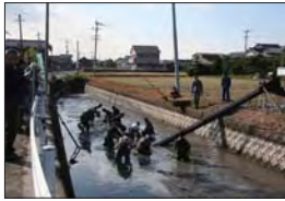
[ 営みの景観 ] ○掘干し
