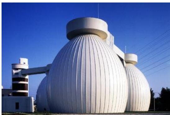
汚泥消化タンク ↓ 消化ガス
