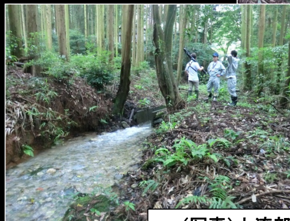
(写真)上流部 素堀区間
