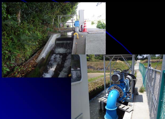
(水路と発電施設)
