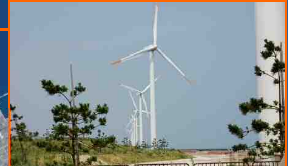
(株エヌエスウインドパワーひびき 響灘風力発電所 1,500kW×10機(H15.3稼働)
