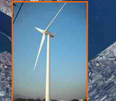
(株)北拓 北九州風力発電所 2,000kW×1機 (H18.11稼働)
