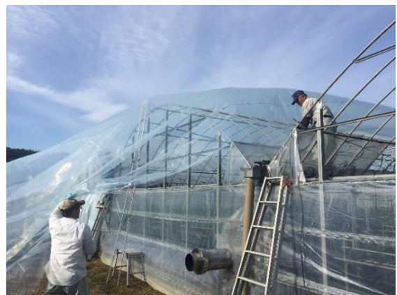
ハウスビニール張りの様子
