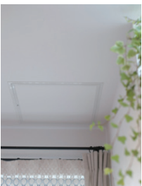
耐震性：I邸は「長期優良住宅」の基準を満たす耐震等級2を獲得。劣化対策：100年を想定した構造躯体であることと、小屋裏や床下を通してその状態を確かめられる点検口を必ず設置することも必須項目。
