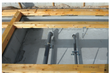
維持管理・更新の容易性：配管の修理・更新、建物全体の維持管理がしやすい家であること。たとえば使用頻度の高い配管などを躯体に埋め込まない設計であることが大事。
