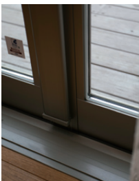
省エネルギー性：機密性の高いペアガラスを採用することにより、少ないエネルギーで室内の温度・湿度調整が可能に。光熱費の削減にもつながる。
