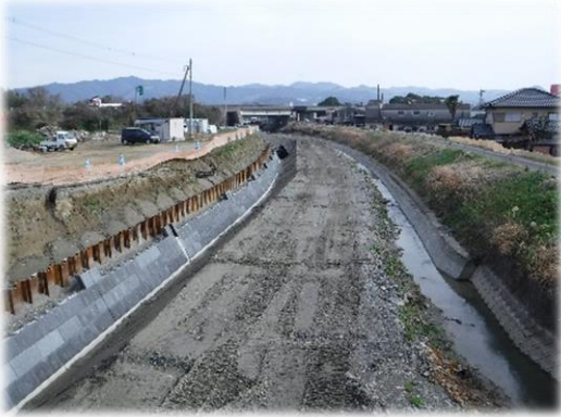
河川の改良工事
