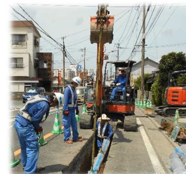
＜配水管の更新工事＞
