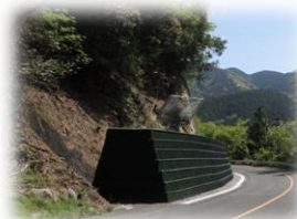
<道路法面の崩壊対策工事>
