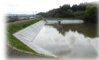
<ため池の改修工事>
