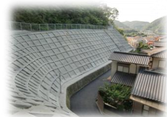
<急傾斜地崩壊対策工事>
