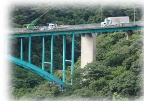
<橋梁の老朽化対策工事>
