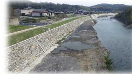
<浸水被害防止のための護岸整備>
