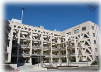
<建築物の耐震改修>
