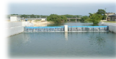
<農業用ゲートの改修>
