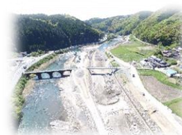
<河川の改良工事>
