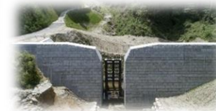
<砂防ダムの設置>
