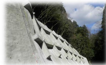
<道路法面の崩壊対策>
