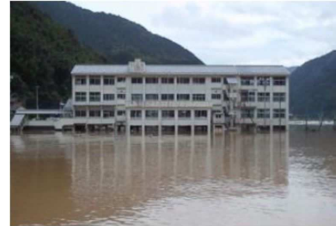
避難所2階の浸水（平成26年8月：徳島県）
