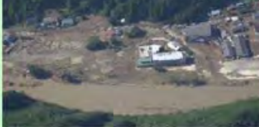
小本川の氾濫による浸水被害状況 (岩手県岩泉町)
