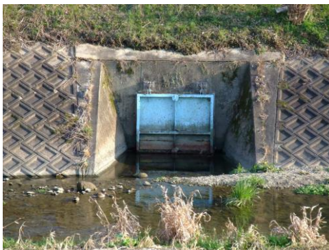
写真 4-1 フラップゲートの整備イメージ
