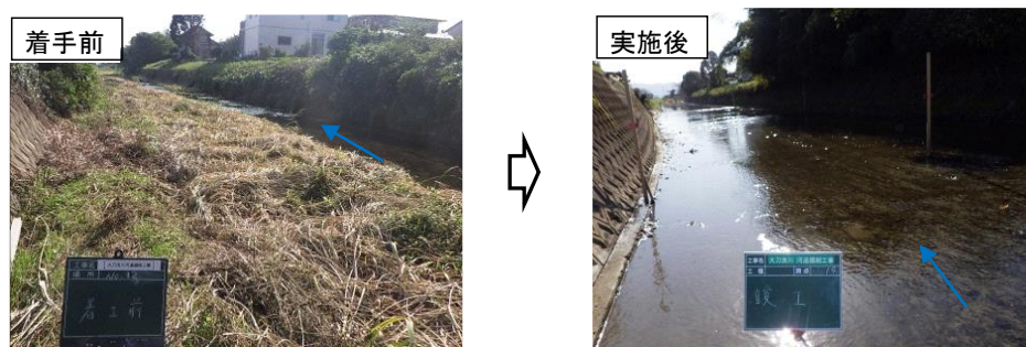
写真 4-2 大刀洗川の堆積土砂撤去実施例
