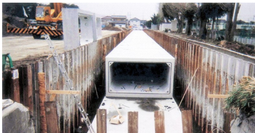
図 4-7 雨水幹線の整備イメージ
