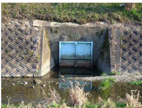
図 4-11 フラップゲートの整備イメージ
