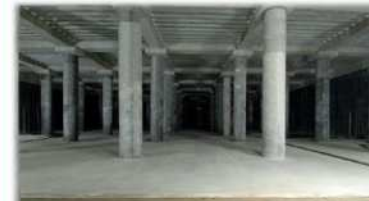
山王2号調整池 約15,000m 3 山王公園の地下に雨水貯留施設を設置
