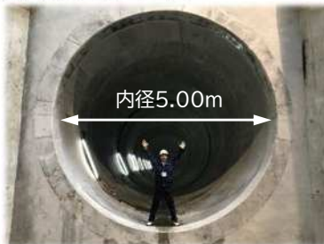
中部2号幹線最下流部
