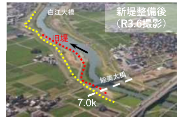
引堤(石川県梯川水系梯川)
