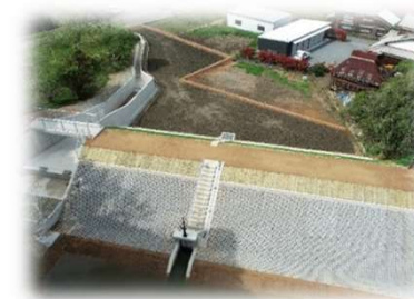
<ため池の改修>
