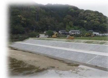
<河川の護岸整備>
