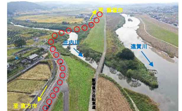
写真①：遠賀川右岸堤防道路不連続箇所
