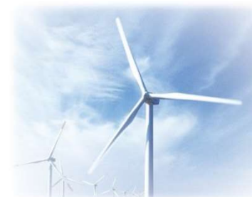
<風力発電設備>
