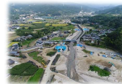
<河川の改良工事>
