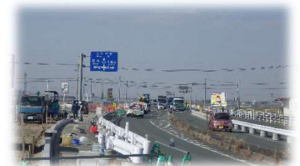
<道路整備の様子 国道442号筑後バイパス>
