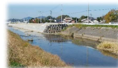
<河川の護岸工事>
