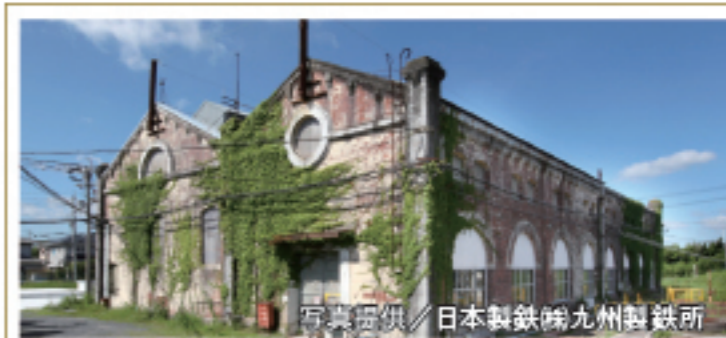
遠賀川水源地ポンプ室 1910年以来、現在も動き続けている製鐵所の送水施設
