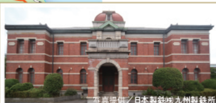
官宮八幡製鐵所 旧本事務所 1899年に建てられ、製鐵所の中心的な役割を果たした初代本事務所
